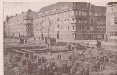
GEZICHT OP EEN GEDEELTE DER BOUWPUT MET INGEHEIDE PALEN
