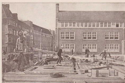
GEDEELTE DER BEKISTING VAN DEN GRONDVLOER BOVEN DE KELDERS
